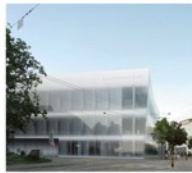
14 Medici ARGE HHF Architekten, CH + Ai Weiwei, China Techdata AG, CH
